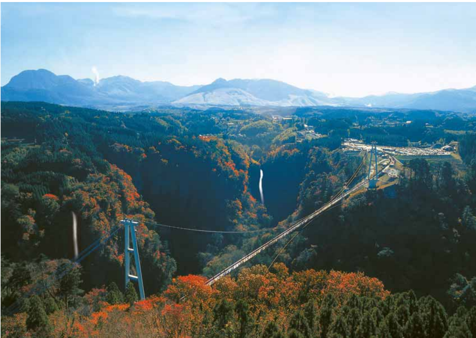
九重「夢」大吊橋
